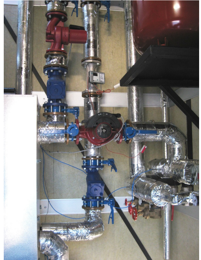
Ohjaushuoneen asennuksia avaimet käteen
