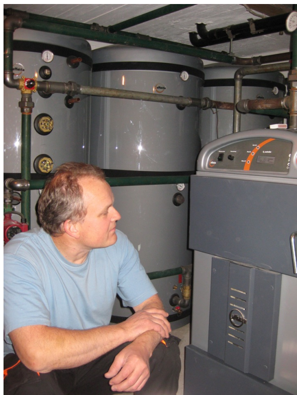
Effecta Lambda 35 kW, 3 kpl 750 litran varaajaa, vasemmassa varaajassa sähkövastukset, käyttövesikierukka ja aurinkokierukka / Effecta Lambda 35 kW, 3 st 750 liters ack.tankar med elpatroner, bruksvattenslingor och solslinga i den vänstra tanken.
