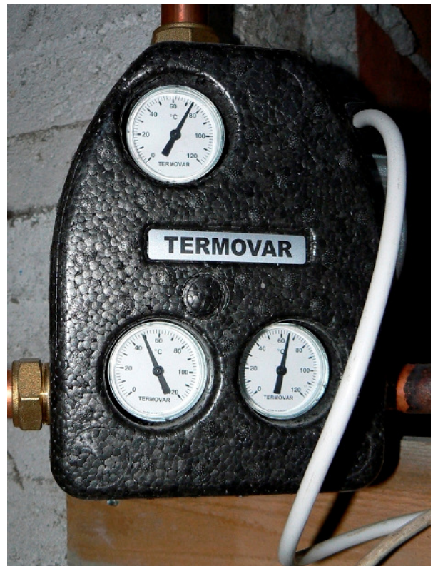
Termovar hoitaa varaajan latauksen / Termovar sköter om laddningen av tanken
