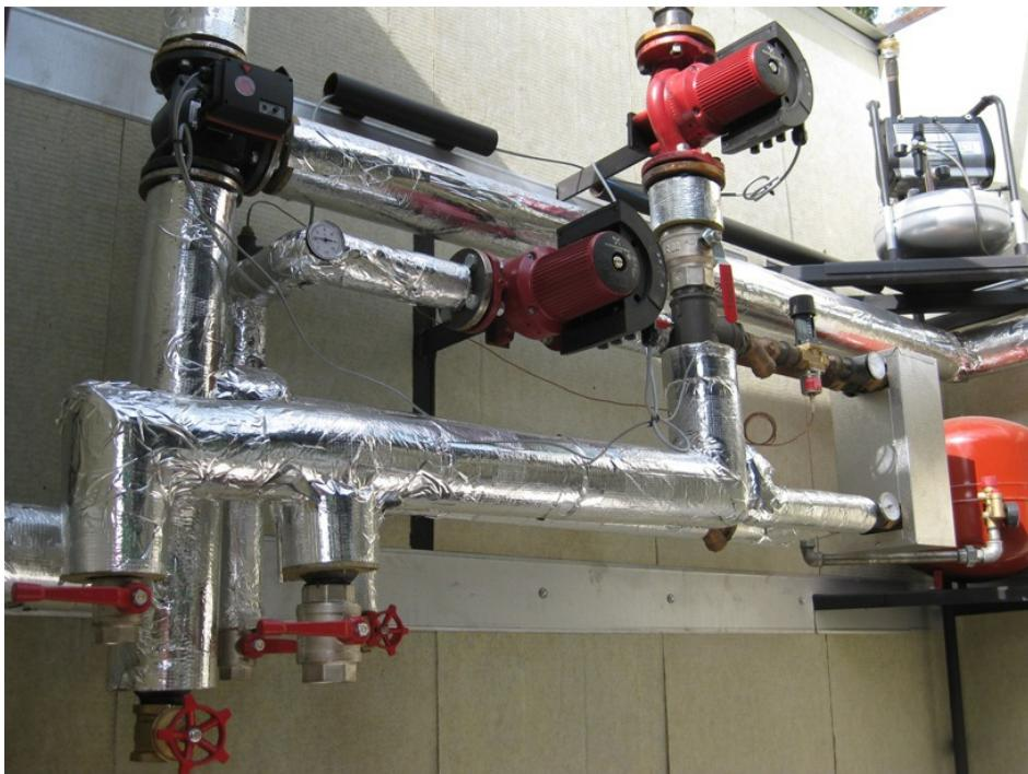
Kattilan ohjaushuone toimitettiin valmiilla putkiasennuksella. Lämönvaihdin omakotitalon piirille, kierroslukuohjattu pumppuja, automaattishuntti, kuvan oikeassa yläkulmassa automaattiuohouksen kompressorit, liitokset ja paikka toiselle kattilalle y.m. Kuvan vasemmassa alakulmassa liitetään lämpökanavat.
