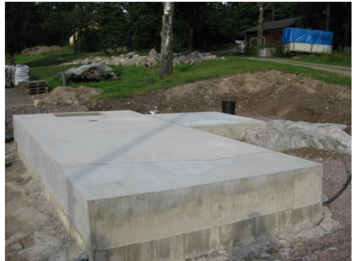
Mats oli saanut laatalle piirustukset Faustilta ja rakentanut kattilalle laatan. Kattila saapui Kolsarbyn tilalle kesiviikkona 5.8.2009. Kuljettajana ja pystytäjänä ammattimies Pjer, jolle sähkölinjat eivät tuottaneet ongelmia.
