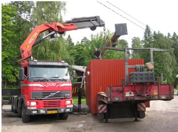
Noin 16 tonnia painava 230 kW:n kattila jossa on 2 m syvä, 1,9 m leveä ja 1,9 metriä korkea polttotila ja 18 m<sup>3</sup> vesitila joka toimii varaajana on nostettavissa kuorma-auton omalla nosturilla.
