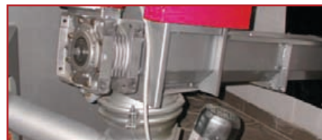
Stokeriruuvi ja pudotuskuilu jossa sertifioitu takapalonesto (stokeriruuvi asennetaan kattilan oikealle tai vasemmalle puolelle).
