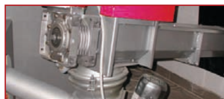
Stokerskruv inkl. fallschakt med certifierad säkerhetsanordning mot bakbrand (helheten valbart monterad på endera högra eller vänstra sidan av pannan).
