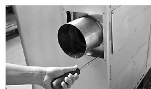
Anslutning sida: Montera först packningen på pannplåten och sedan rökstosen
