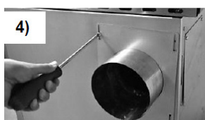
4) Anslutning sida: Montera den yttre flänsen
