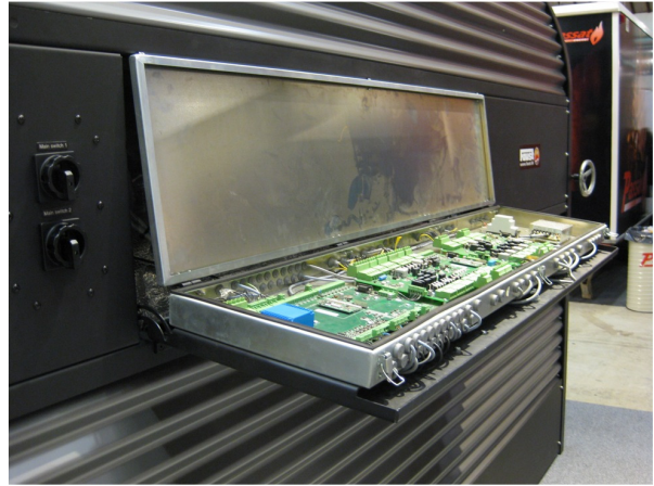
Kuva 5. Ohjausyksikkö kattilan kyljessä
