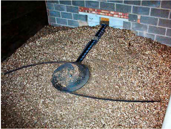
Kuva 3. Jousipurkain polttoainevarastossa ylhäältä katsottuna.
