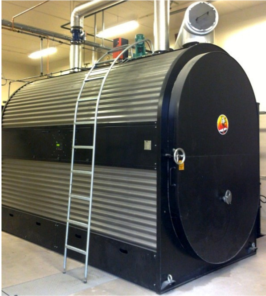
Kuva 1. Faust Bio-Flow II Heavy Duty 970 kW
