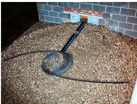
Bild 3. Matningsfjädern (sedd uppifrån) i ett bränsleförråd.
