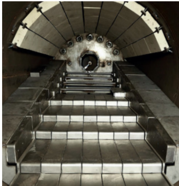
Bild 2. 970 kW brännare med rörlig trapprost.
