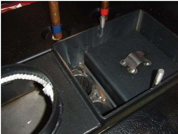
Kattilan yläpuolella kannen alta löytyy putket, missä suoritetaan nuohous ja puhdistus.
