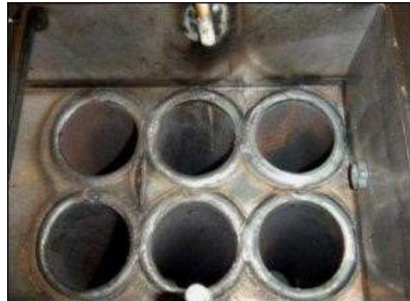
Tässä näkyy putket ilman savukaasujarrua, mikä näkyy vasemmanpuoleisella kuvalla.
