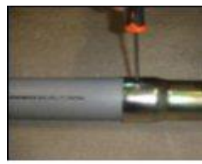
14. Fäst plaströret med medföljande skruv.
