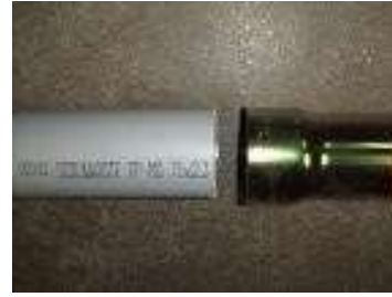
3. Näin muoviputki ja pääteputki yhdistetään.
