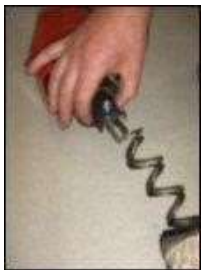
7. Kiinnitä kiinnityslevy ja ruuvi ja kierkeitä ruvikierukkaa kohti.
