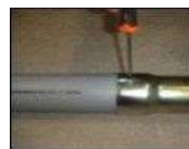
14. Kiinnitä muoviputki ruuvilla.
