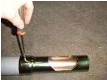
4. Yhdistä muoviputki ja pääteputki ruuvilla.
