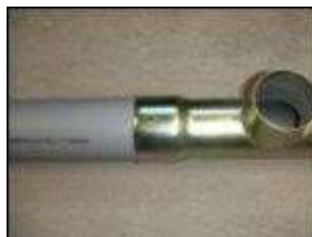
13. Muoviputken ulostuloreikä on oltava 180 astetta verrattuna T-putken ulostuloon.
