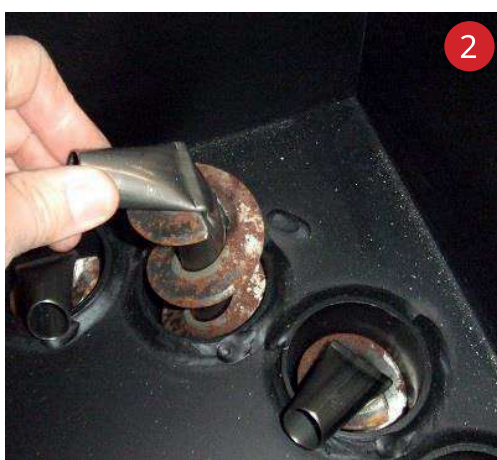
2. Drag upp turbinatorerna cirka 10-15 cm och släpp ner. Upprepa ett par gånger.
