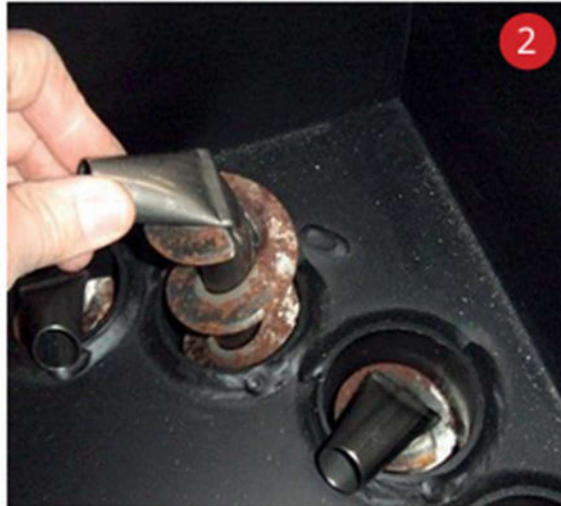
2. Vedä turbulaattoriputket ylös noin
