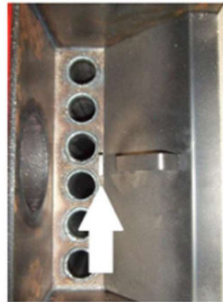
4. Varmista, että suojalevy asennetaan paikalleen oikein. Katso yllä olevasta kuvasta
